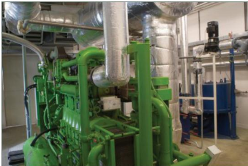
Obr. 13 - Pohonná jednotka vyrábějící elektr. energii (výrobce GE) - výkon 330 kW
