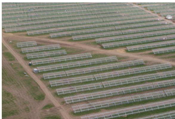
Obr. 5 - Solární elektrárna Vepřek, okr. Mělník
