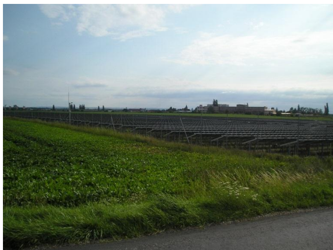
Obr. 17 - Fotovoltaická elektrárna Nymburk - Veleliby (Polabská nížina)
